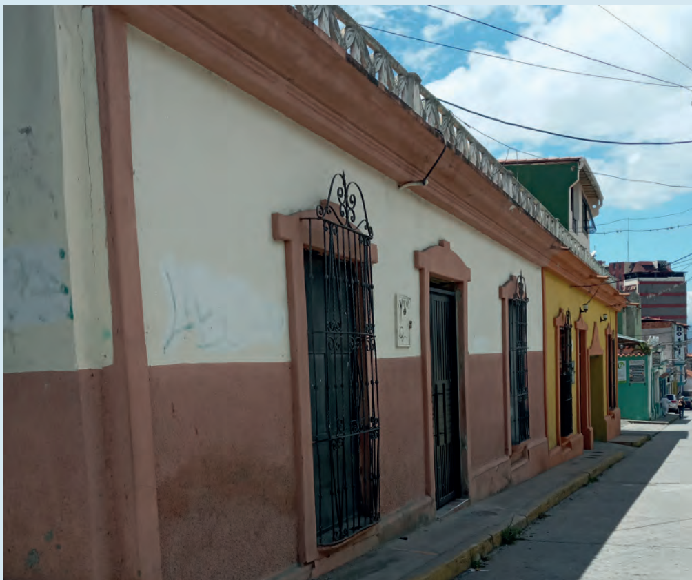
El Dispensario de San José (Mérida, Venezuela) se encuentra en obras.
